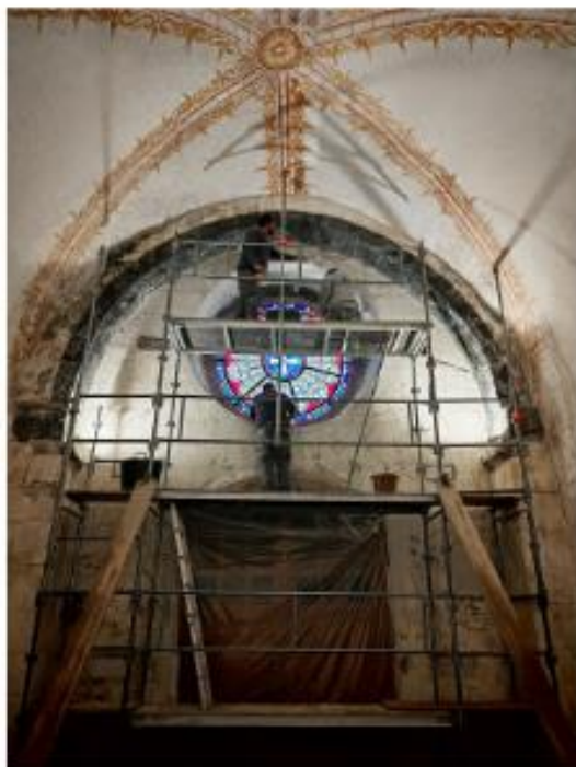
Réfection et étanchéité d'un mur l'Eglise
