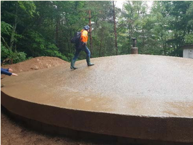
Réfection de la couverture du dôme du réservoir de Gouttenoire
