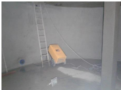
Fin de rénovation du réservoir de Brissay
