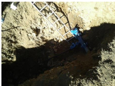
Création d'un Bypass à Tartaru
