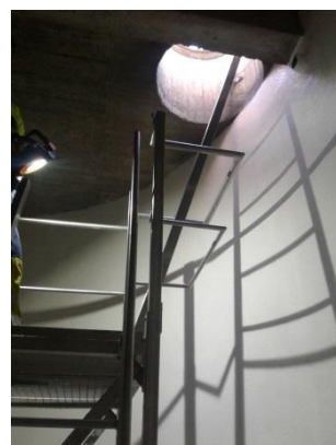
Installation d'une plateforme avec platelage pour accès en sécurité à Tartaru
