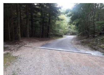
Travaux hors programme CCPU : La montée au château d'eau des Grands Champs pour 8236 € HT
