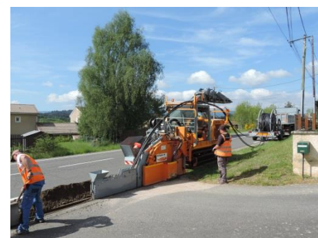
Pose de la fibre à Fauchemagne
